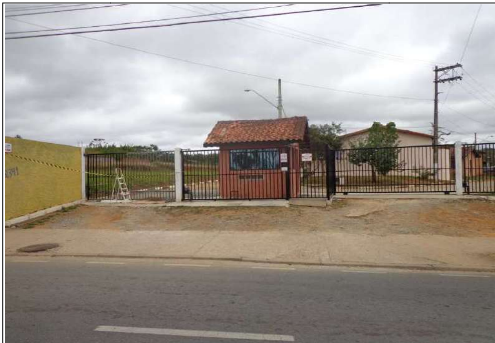
Foto 02 – Vista da portaria que dá acesso ao interior do imóvel.
