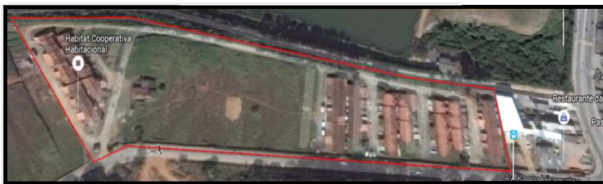
Figura 2 – Vista aérea do imóvel constricto (gleba de terras) e das construções nela edificadas.
