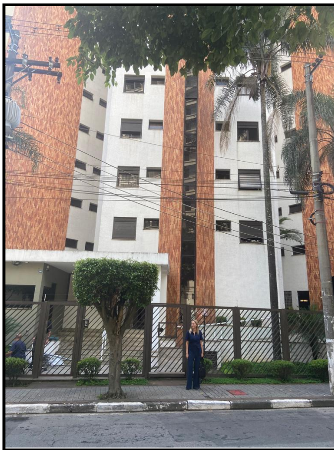
Foto 2: Edifício Marie Helene
