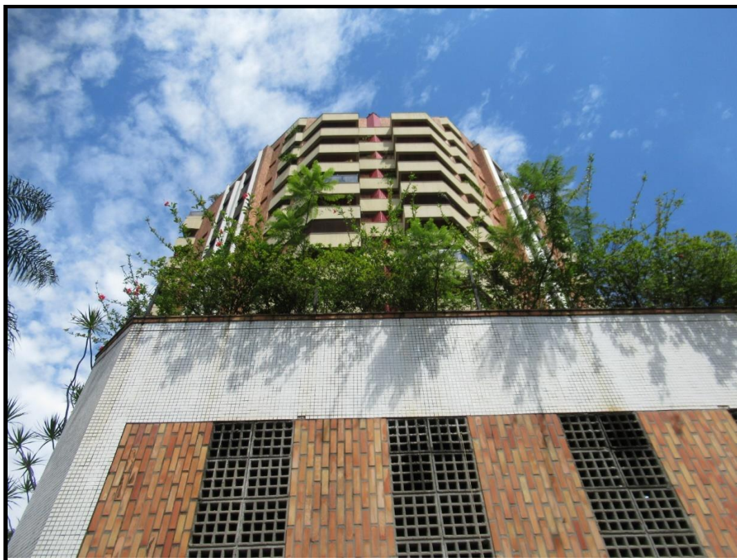
Foto 17: Edifício Marie Helene
