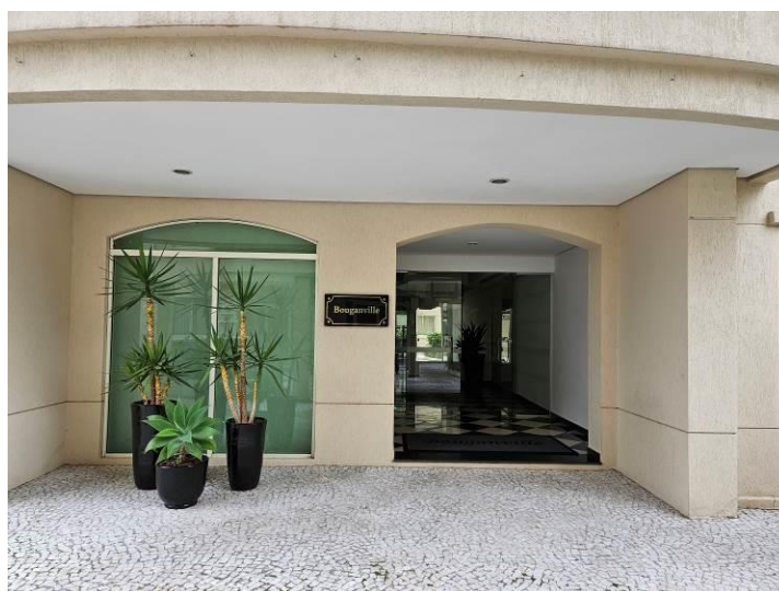
Foto 12: Vista da entrada social do Edifício Bouganville
