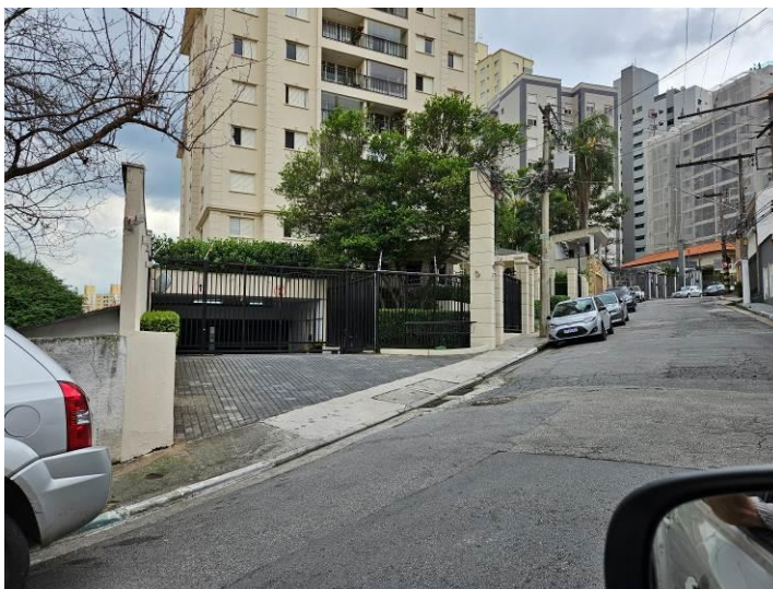
Foto 4: Vista do acesso de veículos para as garagens no 1º e 2º subsolo, à esquerda da entrada principal do Condomínio, de quem da via para ele olha
