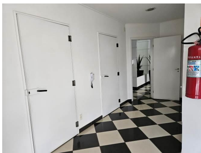
Foto 32: Hall das escadas no térreo dos edifícios
