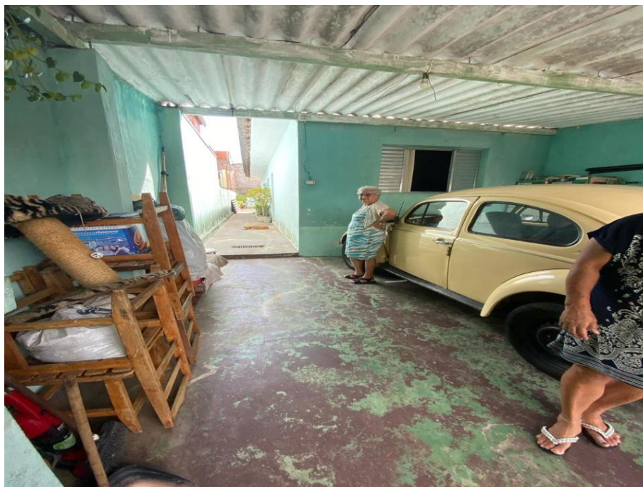
Vista do recúo/garagem
