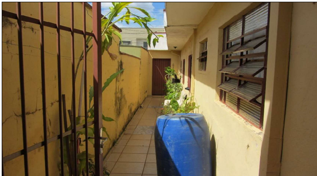
FOTO 07: Vista do corredor externo lateral.
