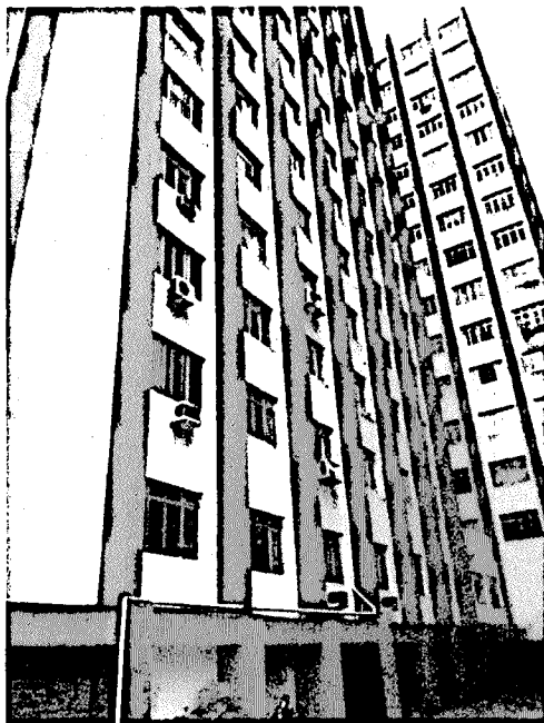
FOTO 02: Vista da Fachada Lateral Direita.
