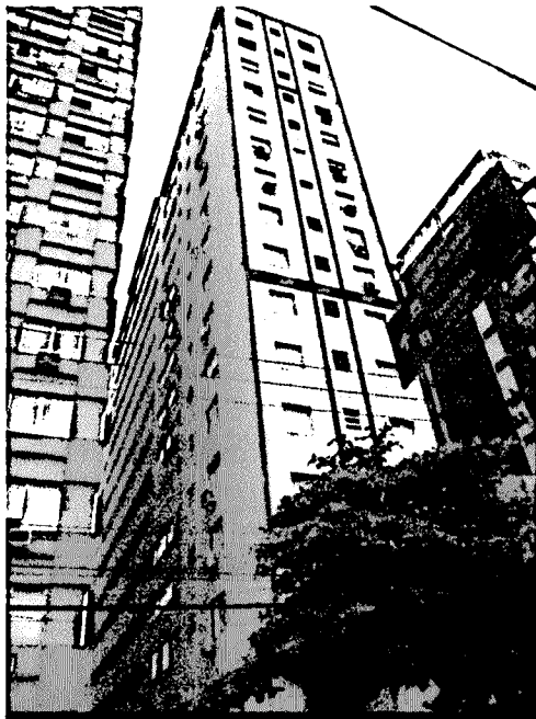
FOTO 01: Vista da Fachada Principal.
