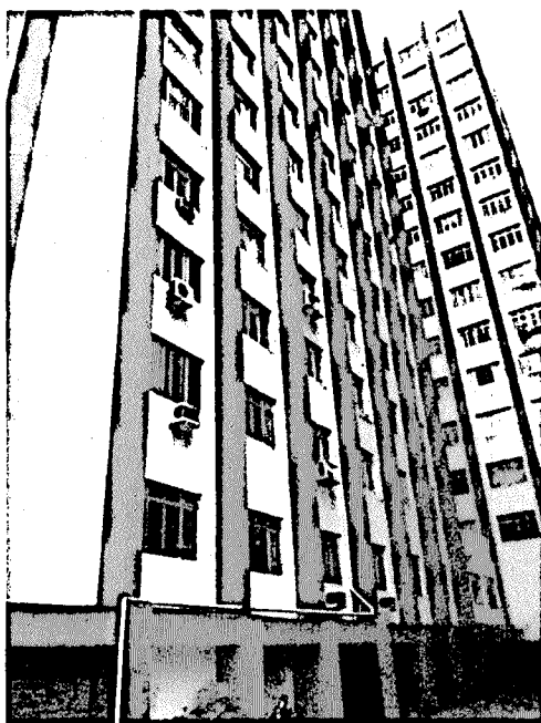
FOTO 02: Vista da Fachada Lateral Direita.
