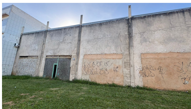
Fotografia 2 - Fachada do imóvel
