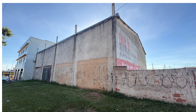
Fotografia 1 - Fachada do imóvel
