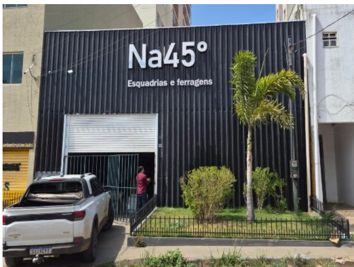
Imagem 1 - Fachada do imóvel
