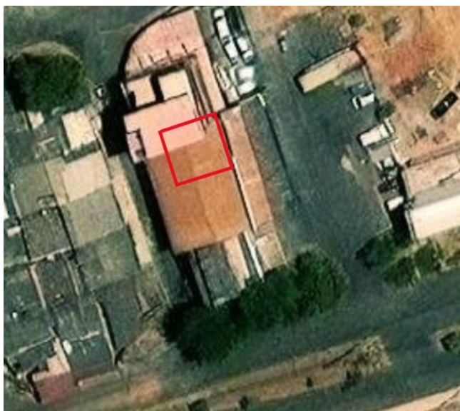
Imagem 1 - Localização do imóvel (Fonte: software Terrageo)
