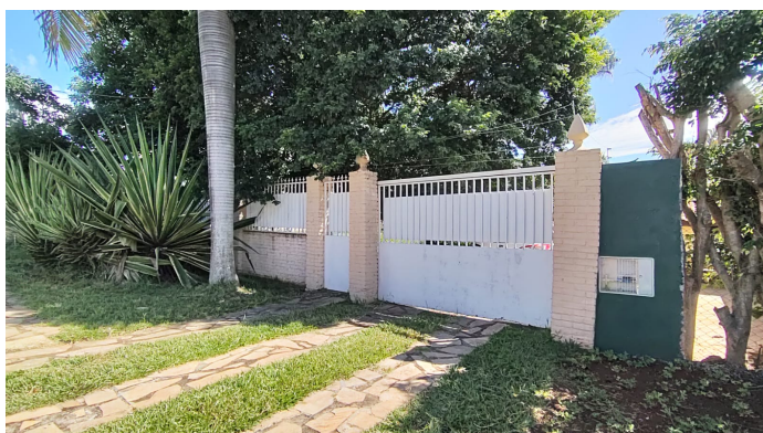
Imagem 1 - Fachada do imóvel
