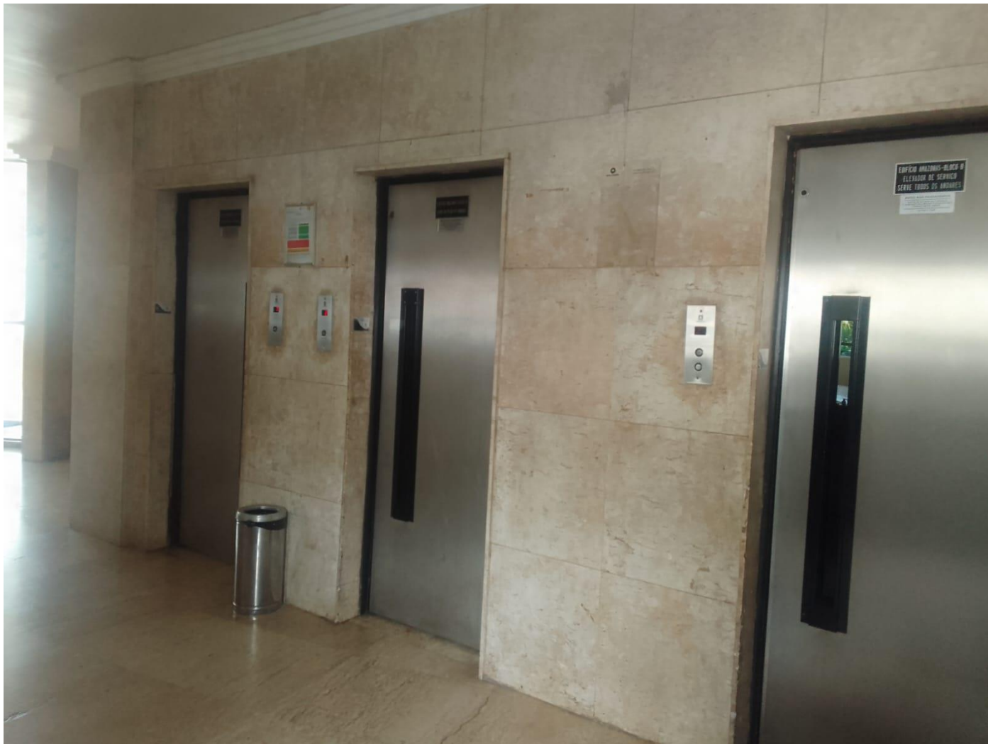
ELEVADORES – SENDO, 2 SOCIAIS E 1 DE SERVIÇO. CONDOMÍNIO E EDIFÍCIO JARDIM TROPICAL
