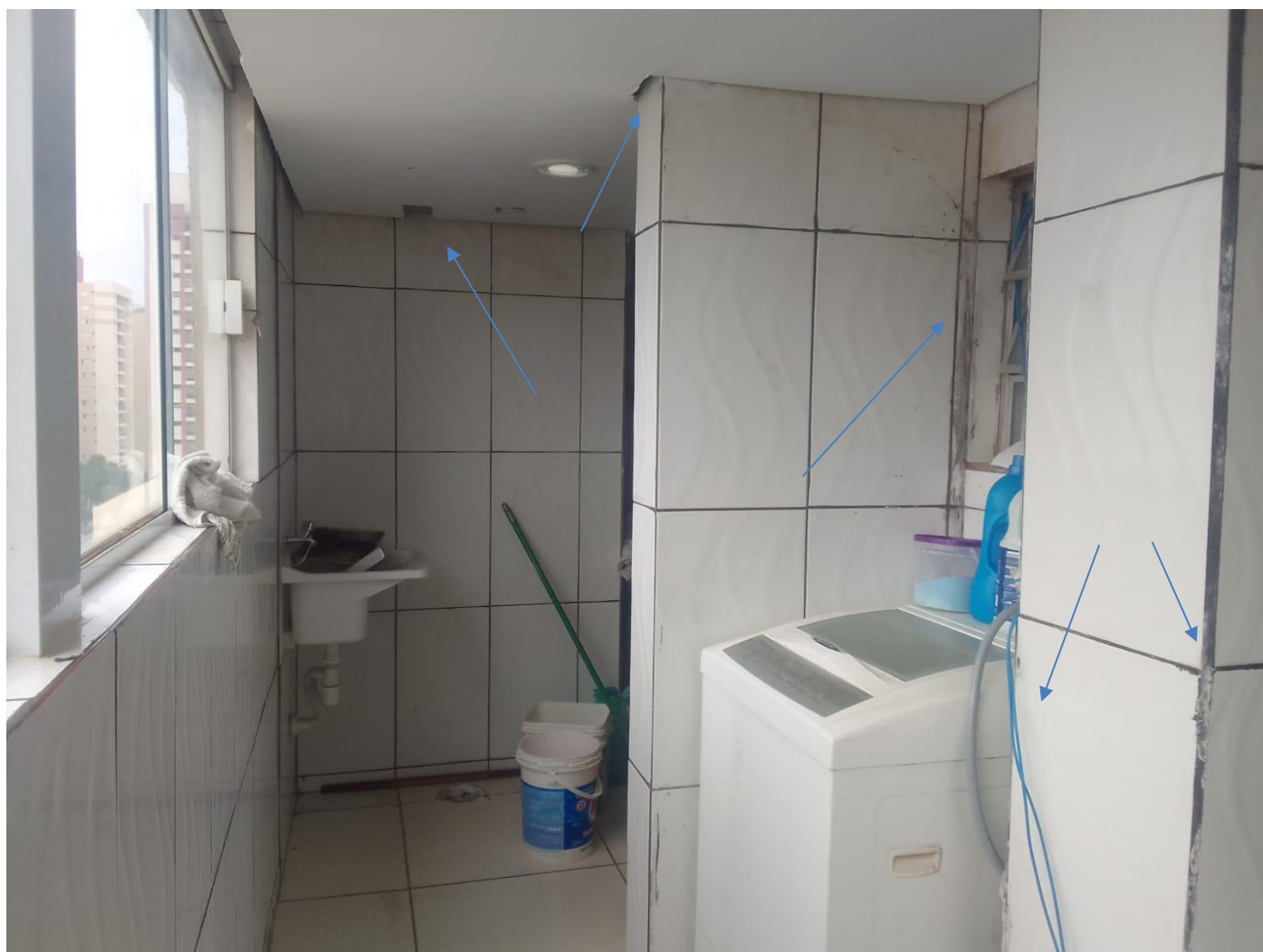
ÁREA DE SERVIÇO – APARTAMENTO 126B – 12º ANDAR.
