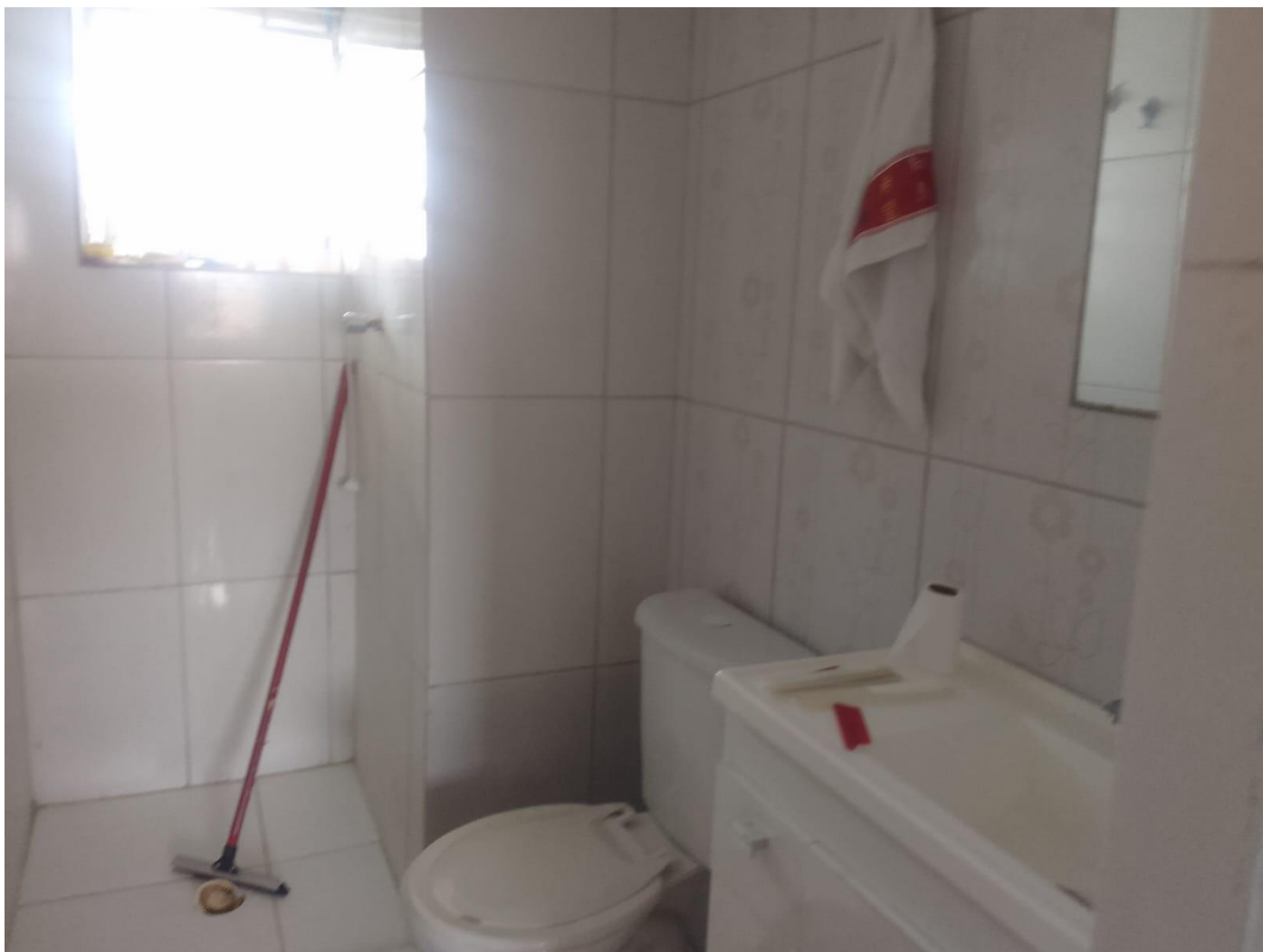
BANHEIRO SOCIAL – APARTAMENTO 126B – 12º ANDAR.
