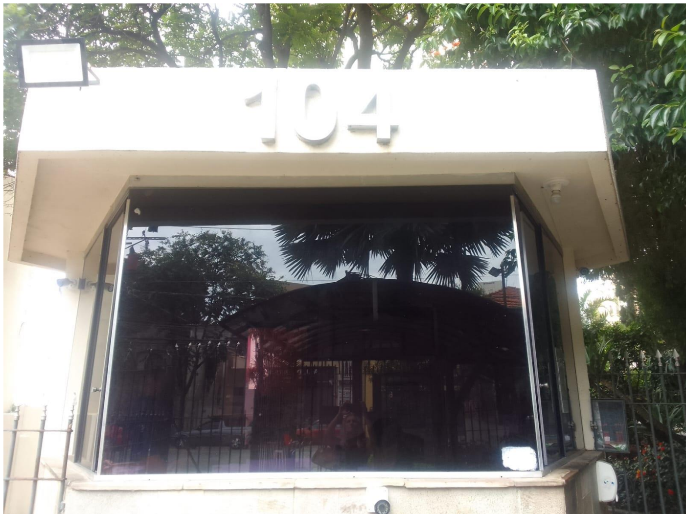
GUARITA – CONDOMÍNIO E EDÍFICIO JARDIM TROPICAL
