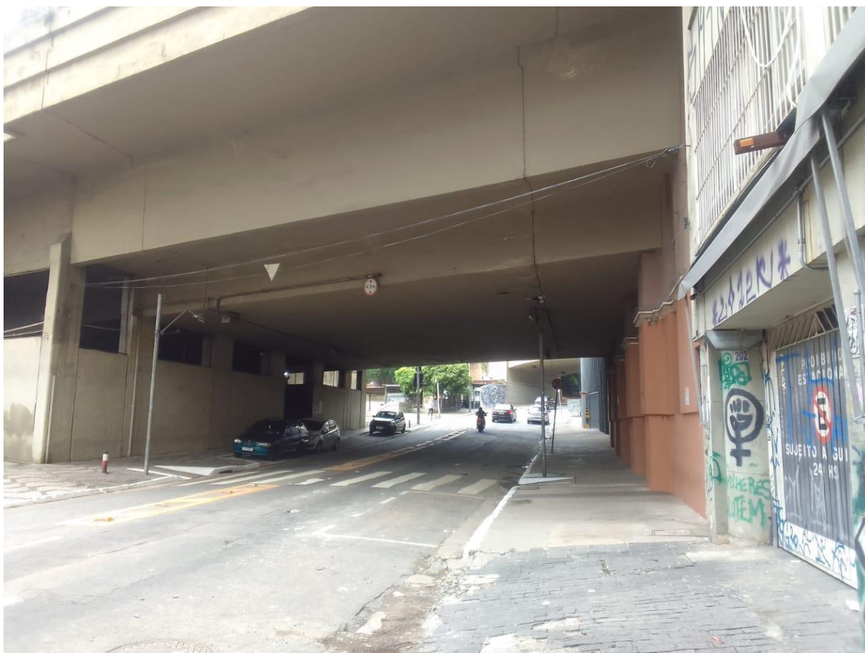
FOTO 14. LADO OPOSTO DA RUA ÁLVARO DE CARVALHO – ACIMA VIADUTO 9 DE JULHO.
