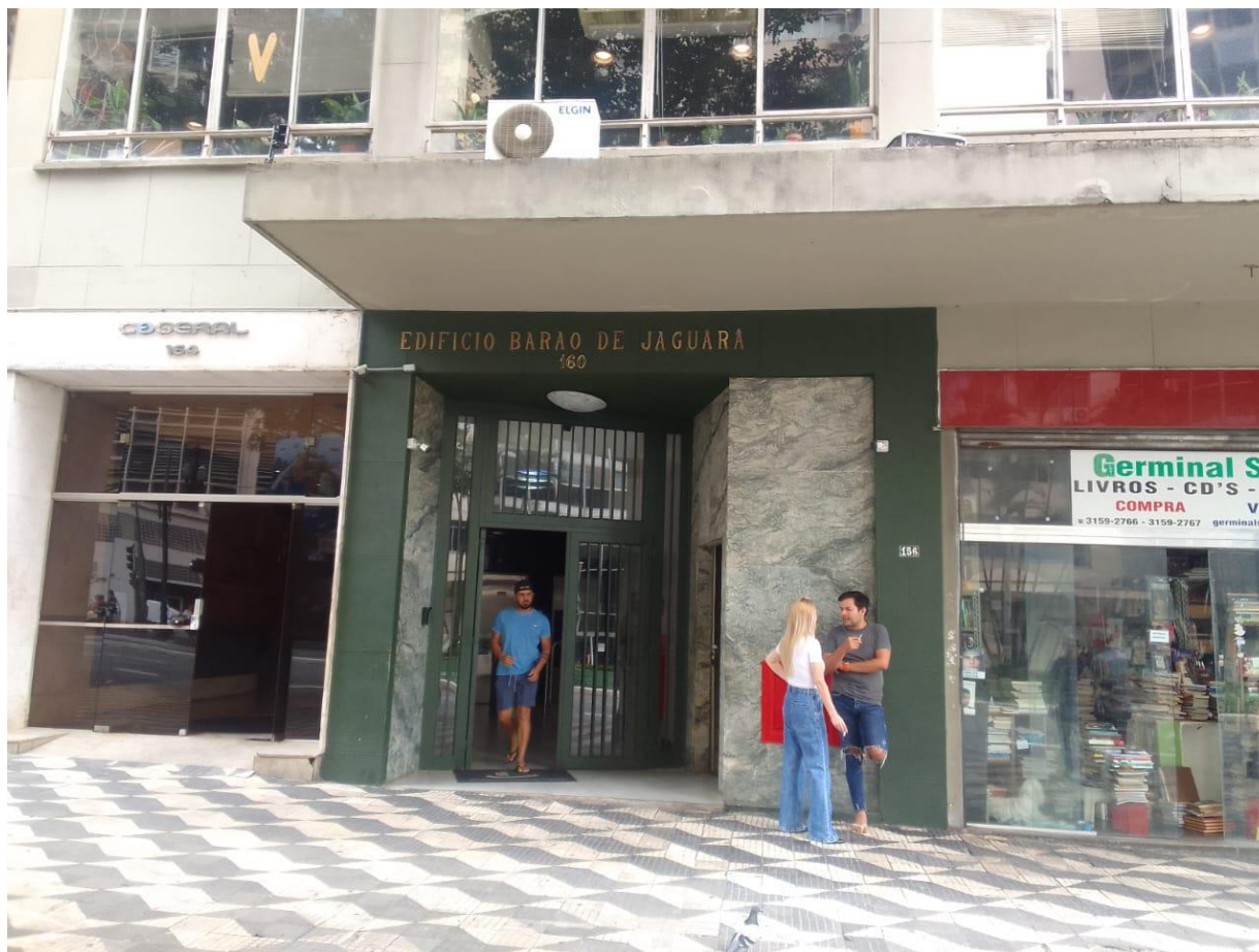
Fachada do Condomínio e Edifício Barão do Jaguará - Viaduto 9 de Julho Nº 160 - República - São Paulo - SP.
