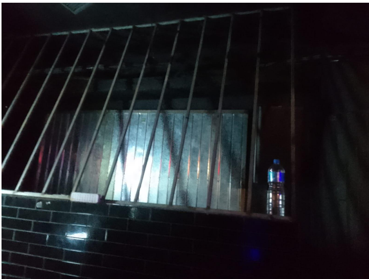
FOTO 11. FRENTE DA CABINE DE SOM NA PRIMEIRA SALA – LOJA Nº 5
