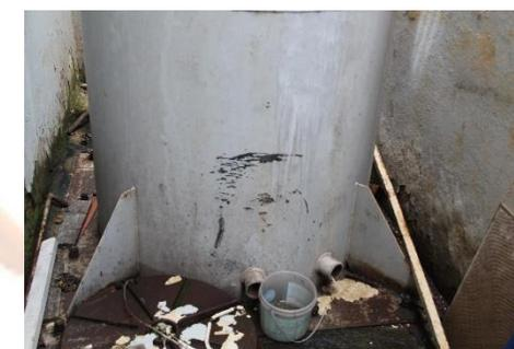
**Lote : 30** Caixa d'água em estrutura metálica com capacidade de aproximadamente de 12.000 litros
