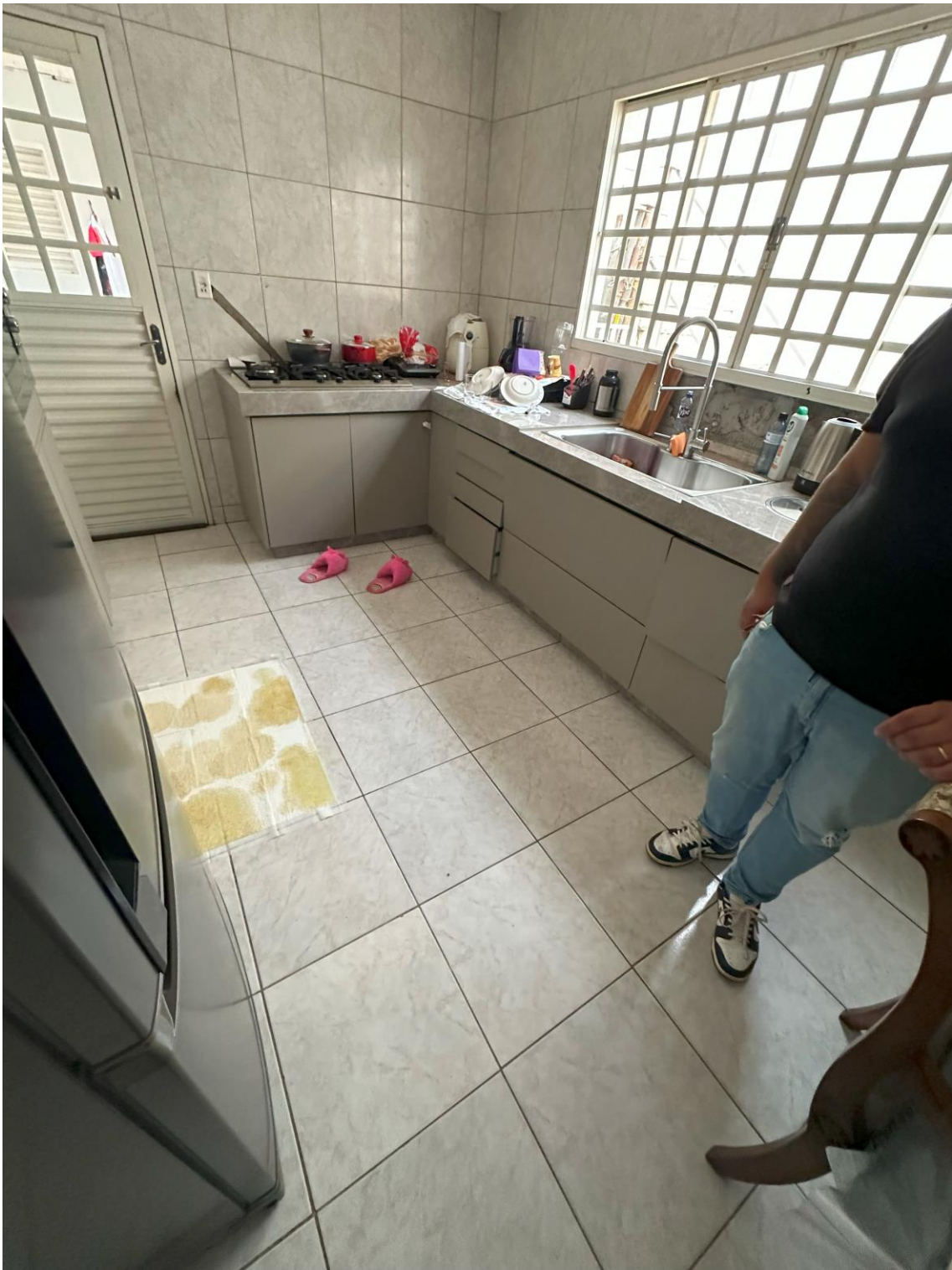
Cozinha – casa principal
