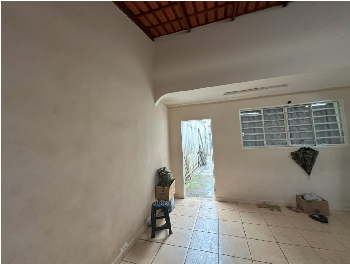
Garagem casa principal / corredor - casa de fundo térreo
