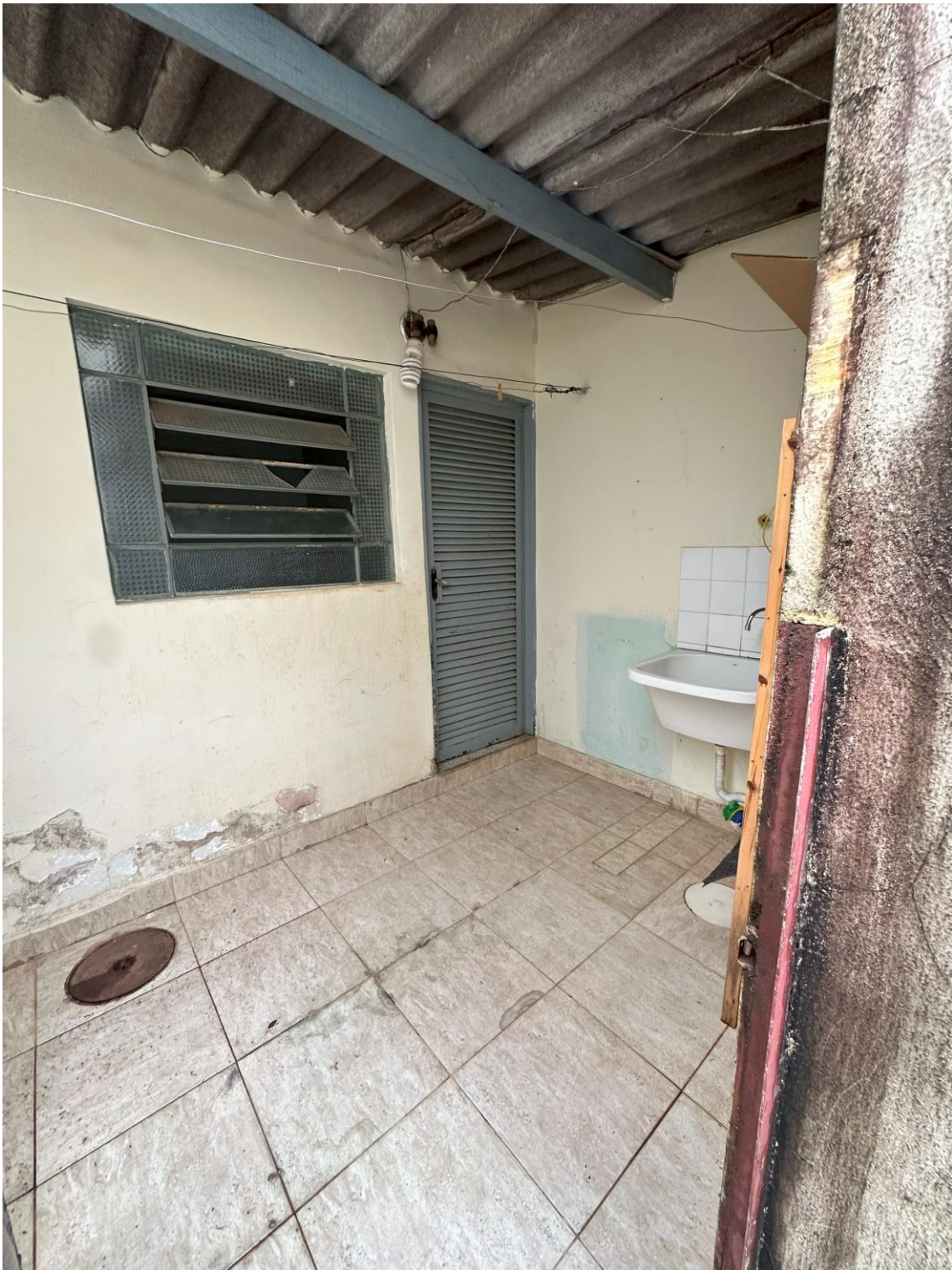
Casa de fundo / área de serviço
