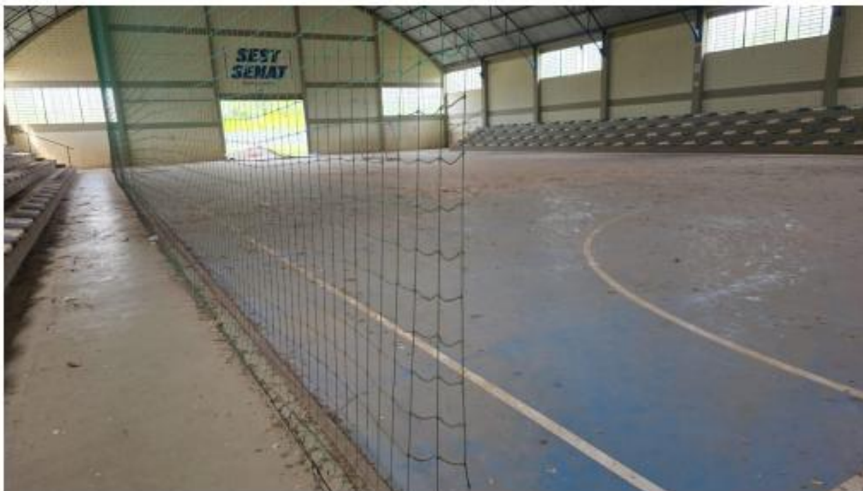
Foto 17: ginásio poliesportivo – vista interna
