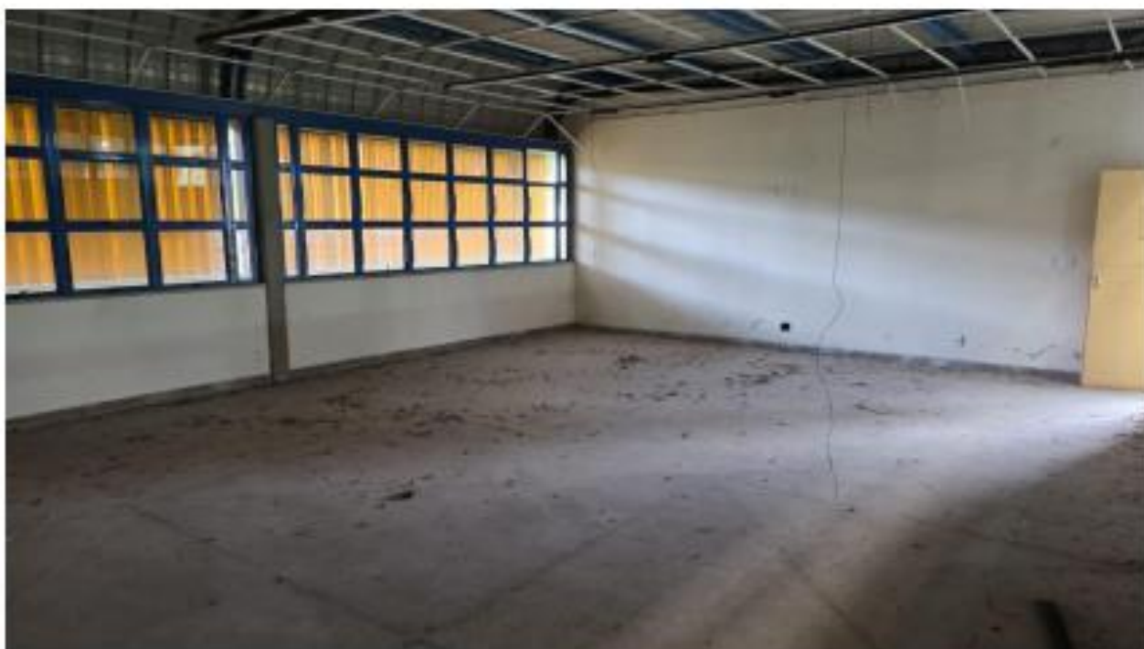
Foto 44: sala de aula
