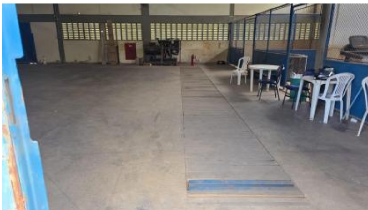
Foto 28: oficina pedagogia – vala existente
