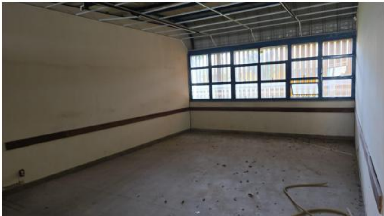
Foto 12: sala de aula – 25 lugares
