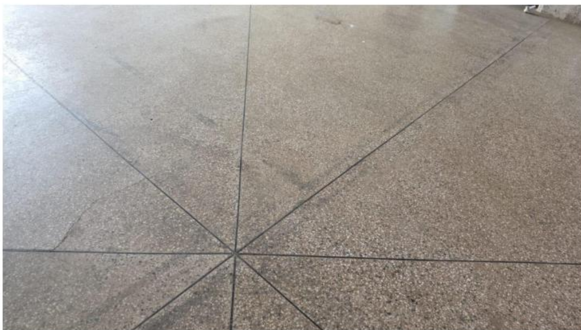
Foto 8: detalhe do piso
