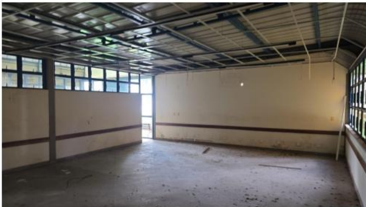
Foto 13: sala de aula – 50 lugares
