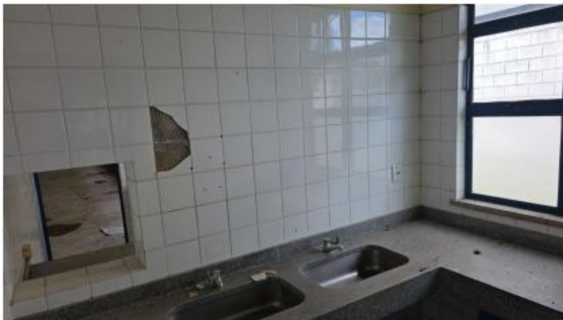
Foto 36: módulo saúde – sala de expurgo
