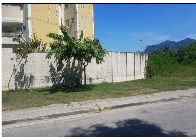
5 TRECHO DO INÍCIO DA RUA SERVIDÃO A - FECHADO PELA VEGETAÇÃO - 17.03.2021
